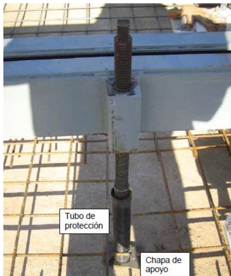
Detalle de colocación de apoyo de la falsa traviesa
